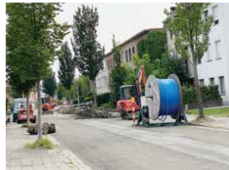
Aanleg van het glasvezelnetwerk
